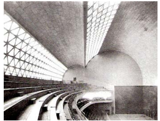
Figure 2.3: Concrete shells. Frontón de Recoletos, Madrid. Eduardo Torroja, 1935, http://veredes.es/blog/monumentos-de-hormigon-inigo-garcia-odiaga/
