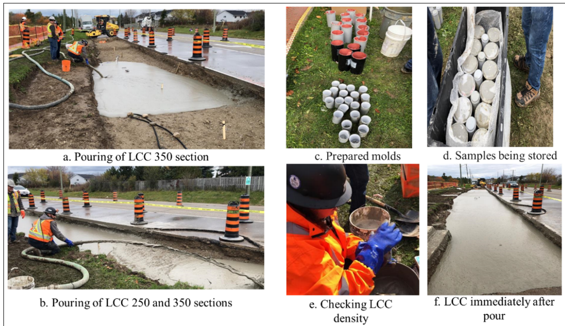
Figure 4.8: LCC pour and sampling
