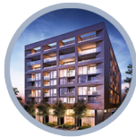
383 Sorauren Ave. Sorauren Condo Under Construction
